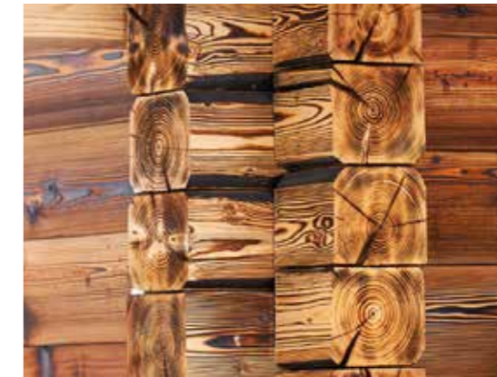
Das Strickmuster an der Fassade ist ein typisches Stilelement aus der Zeit der Walser
