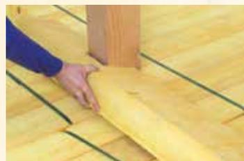
Die einzelnen Dämmplatten lassen sich schnell an Stützen, Mauerrand und Kamine anpassen.
