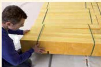
Mit dem Dämmstoffmesser kann man die Dämmplatte präzise zuschneiden und Ausnehmungen für Installationen herstellen.
