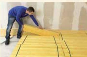
Für Passstücke werden die Bänder entfernt und die einzelnen Lamellen eingesetzt. Die DL Dämmplatten sollten möglichst dicht gestoßen und lückenlos verlegt werden.
