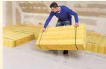
Die Dämmplatten werden in ganzen Elementen aneinander gereiht. Die Bänder dienen als Tragegriff für eine einfachere Verlegung und müssen nicht entfernt werden. So kann rasch verlegt werden.
