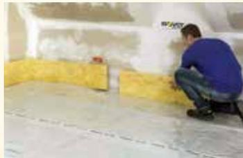
Überlappung der Folie mit Klebeband verkleben. Die Dampfbremse am Rand hochziehen und mit Dichtmasse luftdicht anschließen. Unebenheiten der Wand ausgleichen. Diese auf die Dicke der Dämmplatten zuschneiden.
