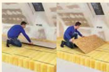
Auf den stabilen Dämmplatten kann zur dauerhaften Begebarkeit ein Belag verlegt werden. Diesen je nach Erfordernis wählen.
