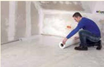
Der Untergrund muss eben sein (sonst mit Beschüttungsschicht ausgleichen). Zwischen unterschiedlich beheizten Räumen ist warmseitig eine Dampfbremse anzubringen.
